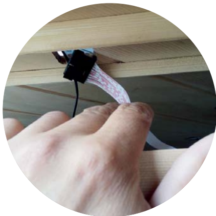
Ukázka protažení kabelů
