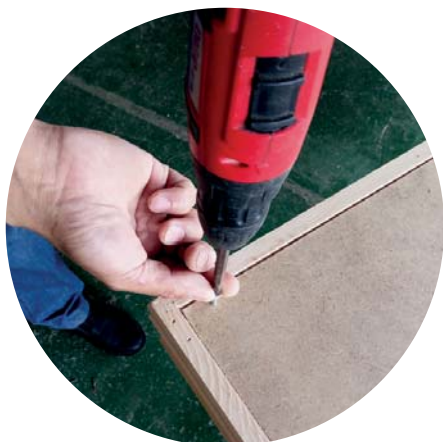
Montáž krytu stropu
