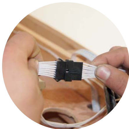
Ukázka propojení kabelů
