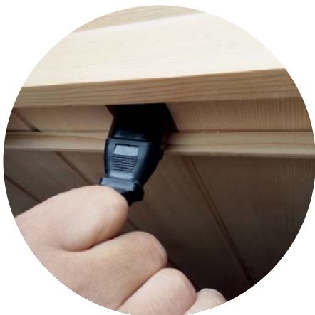
Ukázka protažení kabelů
